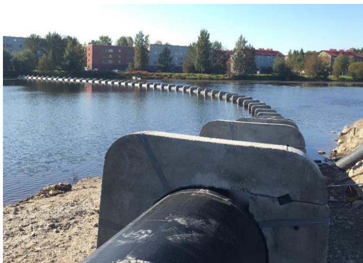
Figur 6.2 Exempel på utförande av rörledning med betongvikter
